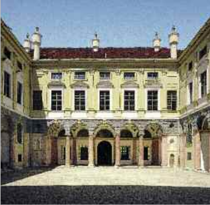
Innenhof der Stadtresidenz nach Westen
